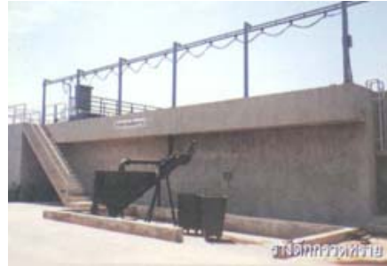
ภาพที่ 2. รางดักกรวดทราย (Grit Chamber)
